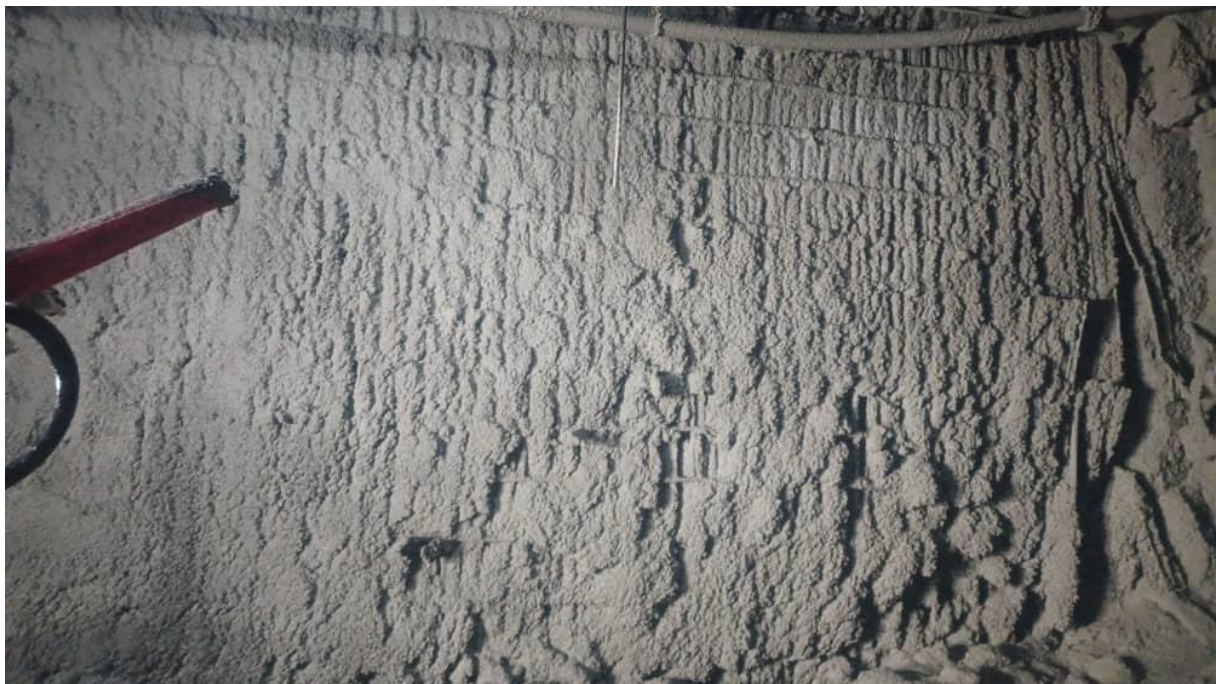
Figure III.5. Système de projeté le béton au moyen de la lance
