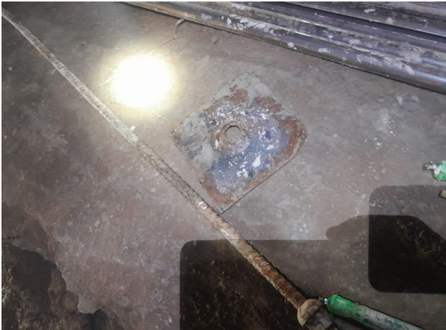
Figure III.3. Boulon à résine avec sa plaque pour le soutènement dans la mine souterraine
