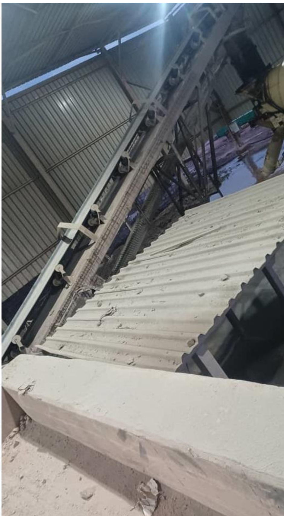
Figure III.9. Bande transporteuse pour le sable et le ciment
