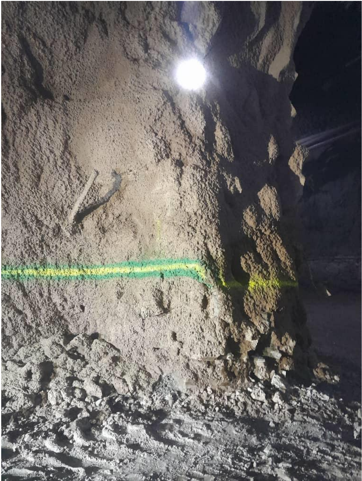
Figure III.14. L'adhérence au niveau du pilier par le béton projeté
