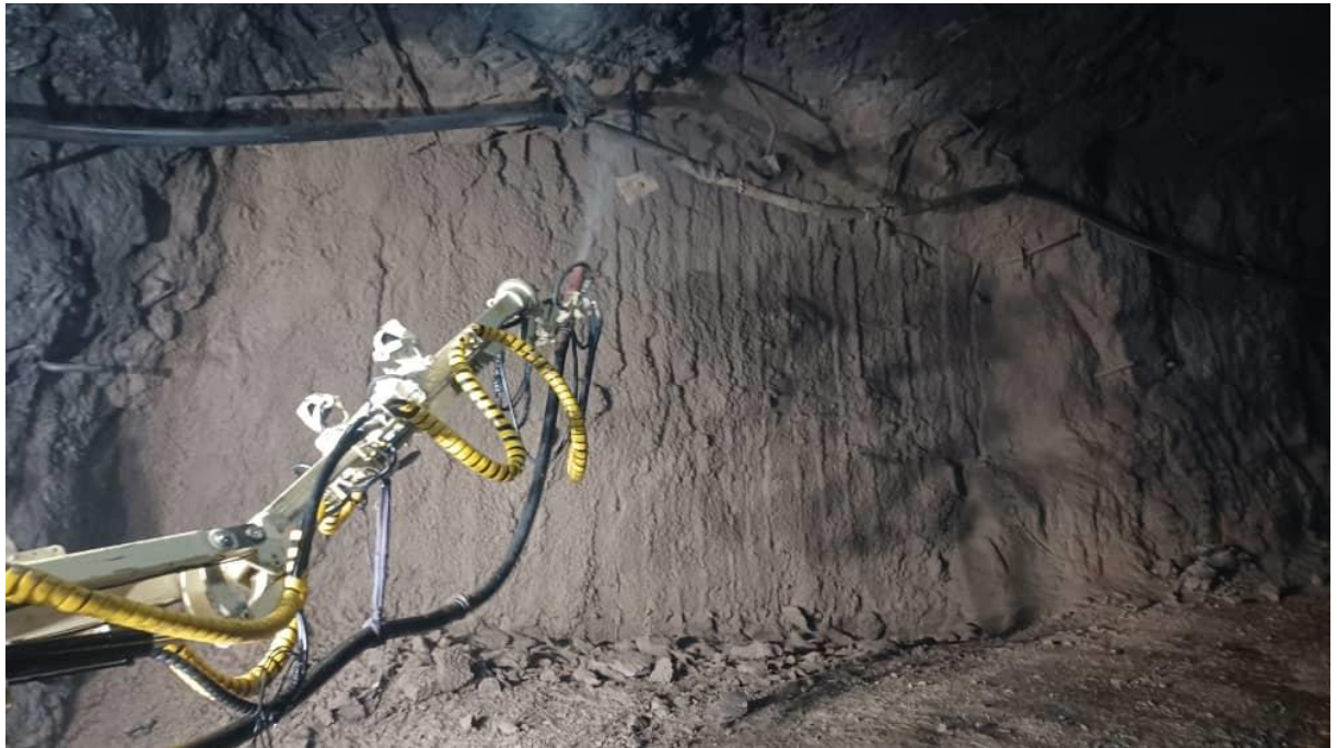
Figure III.5. Système de projeté le béton au moyen de la lance
